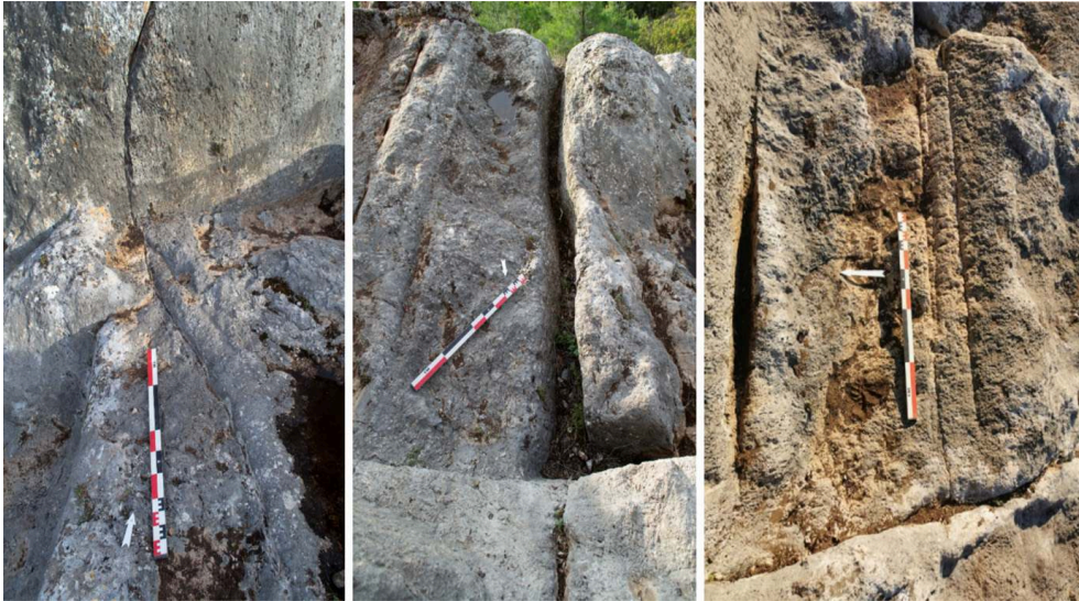
Fig. 13. Fissures exploitées pour la délimitation et l'extraction des blocs. a. STA-U1-F021 ; b. STA-U1-F016 ; c. STA-U3-F013.
