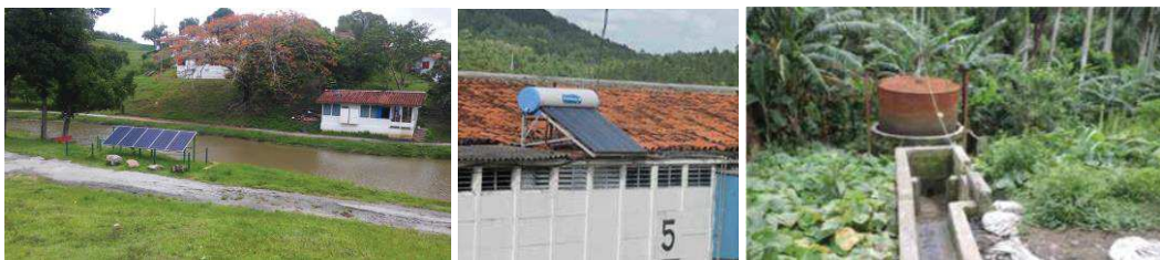
Figura 6: Uso de las Fuentes Renovables de Energía en Las Terrazas. Fuente: Colectivo de autores.
