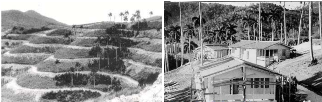
Figura 2: Transformación de las montañas en terrazas y construcción de las primeras edificaciones. Fuente: Archivo del ecomuseo de Las Terrazas.
