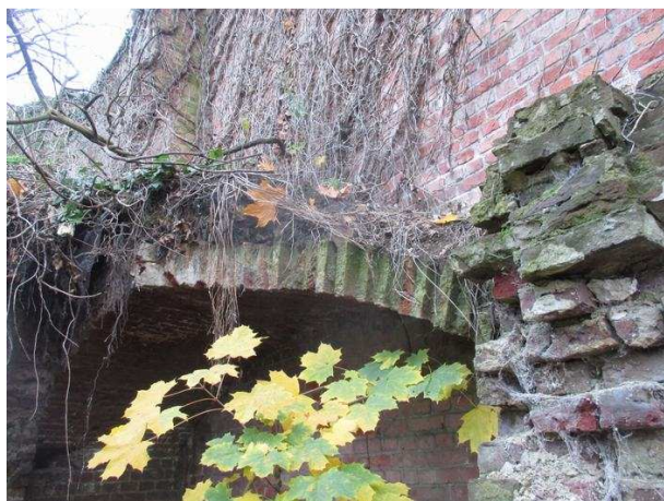
Figuur 9 – (a) Restanten wand tussen noordelijke kelder 2 en 3 en tongewelf boven kelder 2; (b) Restanten tongewelf boven kelder 2
