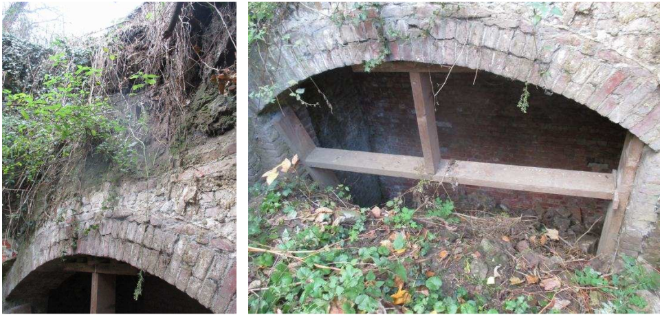
Figuur 12 – Gordelboog tussen centrale gang en noordelijke kelder 1
