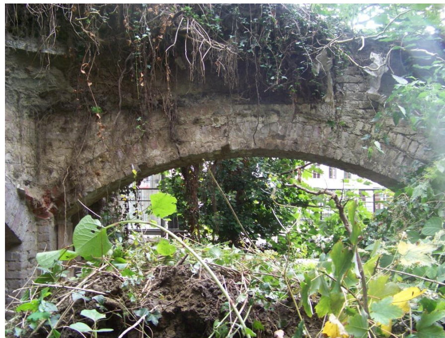
Zicht op de laatste scheidingsboog tussen het eerste en het tweede keldervertrek (gezien vanuit de tunnelgang in de richting van de Schelde-oever).
