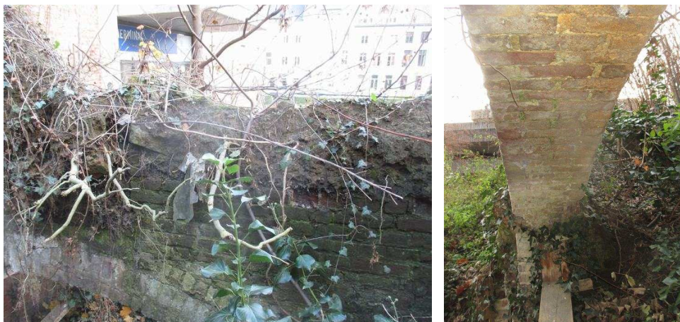
Figuur 20 – (a) Detailfoto Opbouw lagen boven gordelboog gang tussen travee 1 en 2 (zicht vanaf travee 1); (b) Onderzijde gordelboog gang tussen travee 1 en 2
