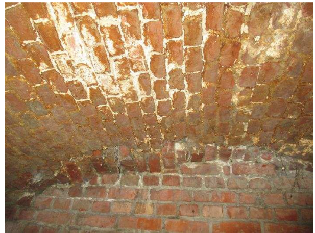
Figuur 10 – (a) Schoring noordelijke kelder 2; (b) Restanten tongewelf boven kelder 2 (onderzijde)
