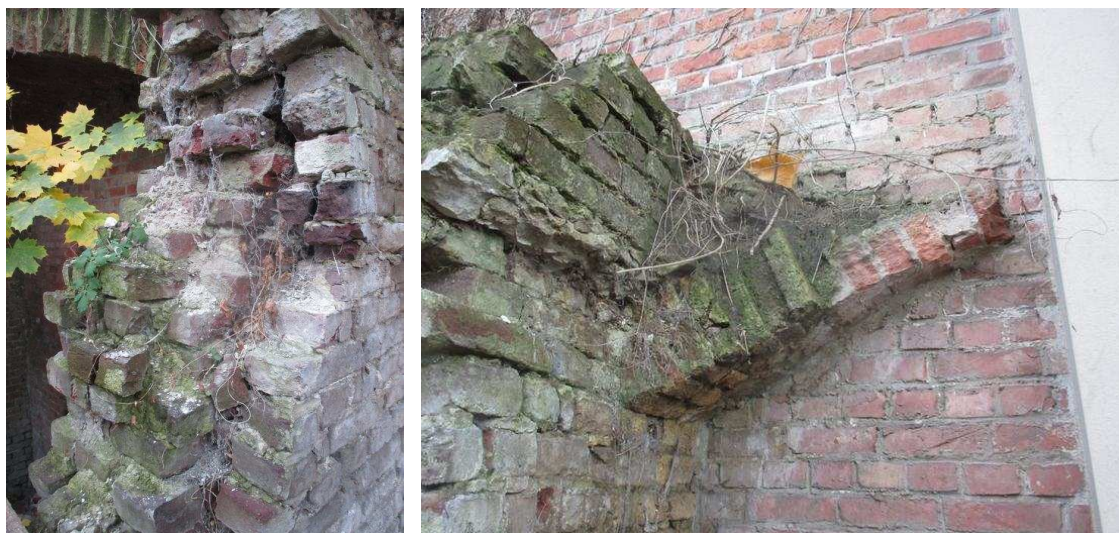
Figuur 6 – (a) Detail restanten wand tussen noordelijke kelder 2 en 3 (b) Restanten aanzet tongewelf over noordelijke kelder 3
