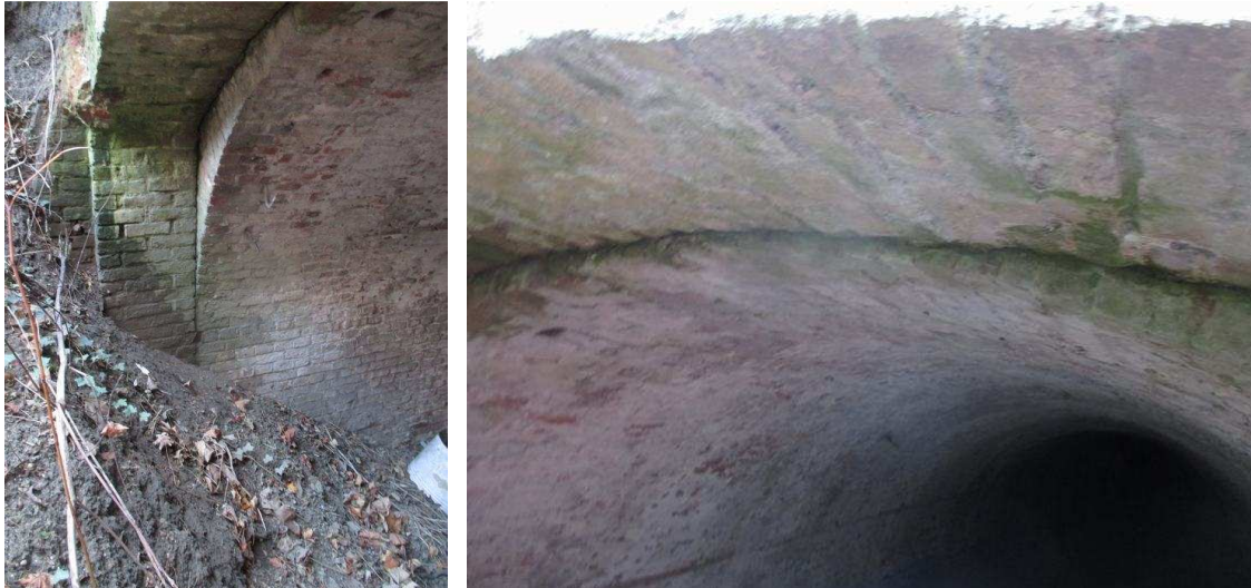
Figuur 17 – Detailfoto overgang tussen overwelfde kelders en ondergrondse tunnel
