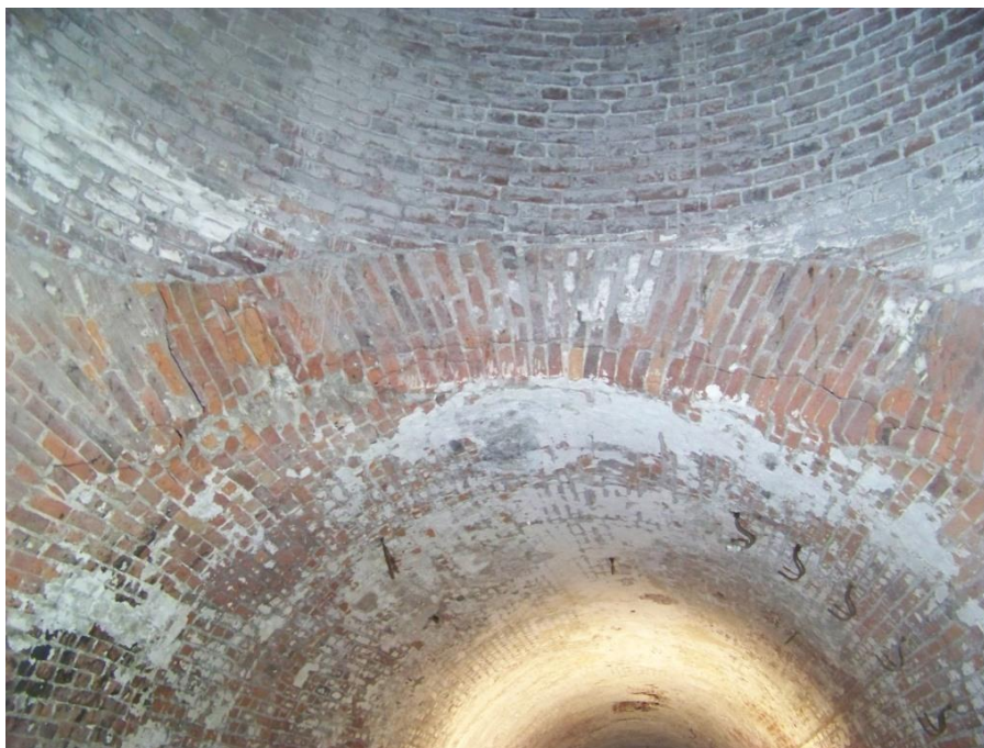
Overgang tussen de rondvormige schacht met het tongewelf van de tunnel, alle uitgevoerd in baksteenmetselwerk.
