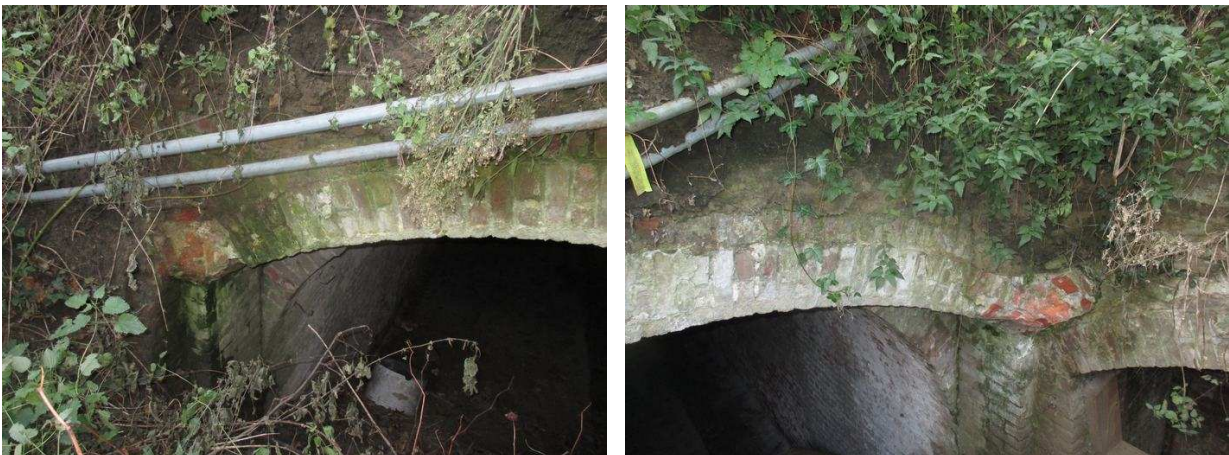
Figuur 16 – Eerste gordelboog centrale gang (overgang met de ondergrondse tunnel), de restanten van de aanzet van het kruisribgewelf zijn in de hoeken links en rechts nog zichtbaar
