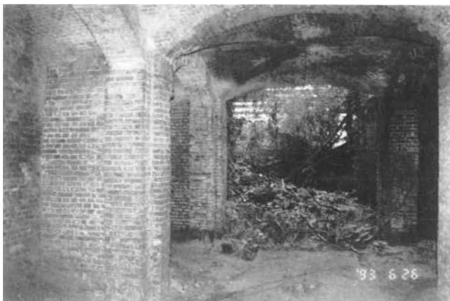
Figuur 2 - Toestand van de kelders in 1993 met zicht vanuit de tunnel: in het midden is het kruisribgewelf van de tweede travee van de centrale gang, vanaf de tunnel geteld, duidelijk nog zichtbaar terwijl het kruisribgewelf van de derde travee ingestort is; de ingekorte noordelijke kelders links op de foto zijn nog in goede staat (bron: Berteloot, 1993)
