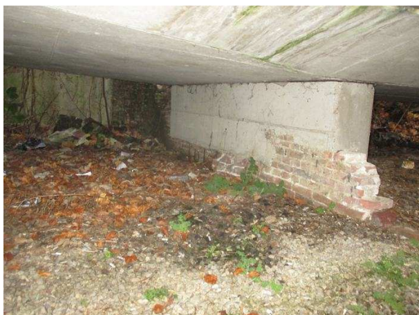
Figuur 8 – Restanten zuidelijke kelder 3 onder pijler passerelle naar studentenhuis De Thermanal
