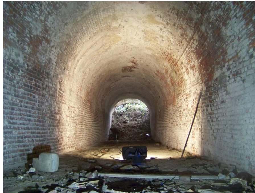
Zicht op de uitgang van de ondergrondse gang of tunnel
