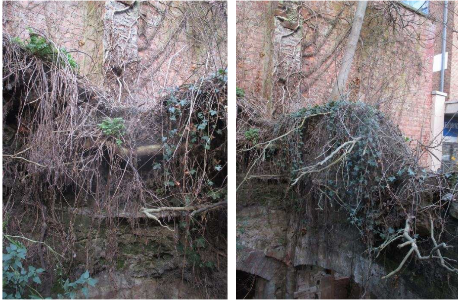
Figuur 19 – (a) Opbouw lagen boven gordelboog gang tussen travee 1 en 2 (zicht vanaf travee 1); (b) Boomgroei bovenop gordelboog gang tussen travee 1 en 2 (zicht vanaf travee 1)
