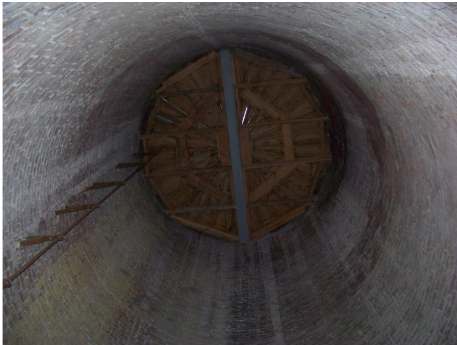
Zicht op de onderkant van de houten plankenvloer van het gelijkvloers in de toren (nivo: 0.00m)
