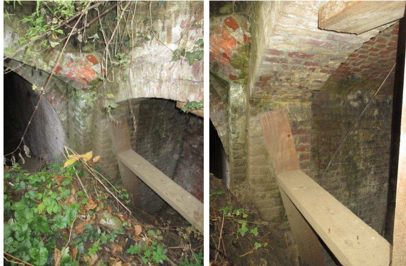
Figuur 15 - Restanten penant tussen noordelijke kelder 1 en de tunnel
