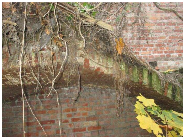
Figuur 9 – (a) Restanten wand tussen noordelijke kelder 2 en 3 en tongewelf boven kelder 2; (b) Restanten tongewelf boven kelder 2
