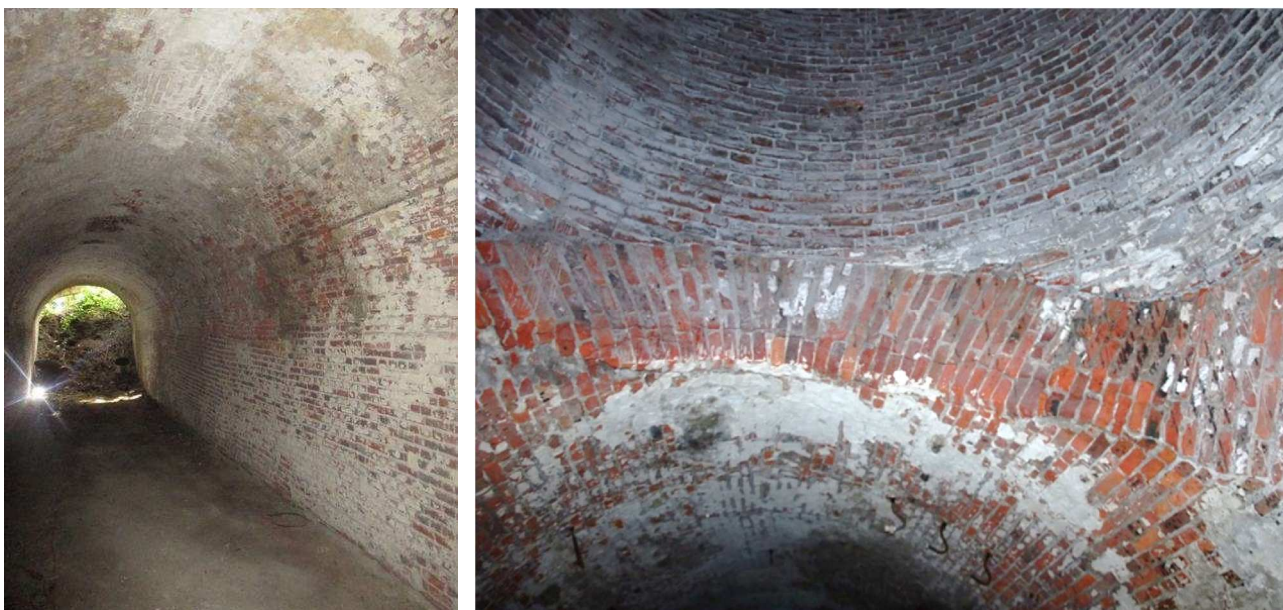
Figuur 28 – (a) Binnenin ondergrondse tunnel; (b) Tongewelf t.h.v. de aansluiting op de vestingstoren
