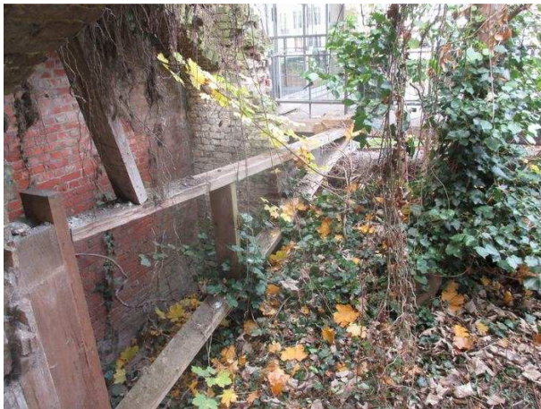
Figuur 10 – (a) Schoring noordelijke kelder 2; (b) Restanten tongewelf boven kelder 2 (onderzijde)
