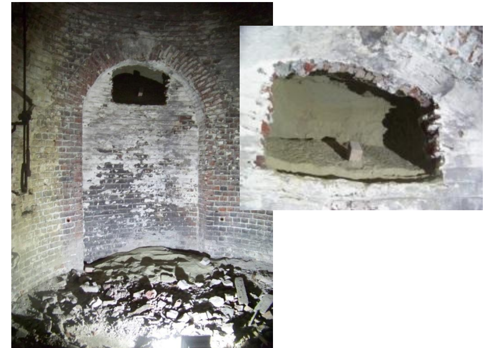
De (dichtgemaakte?) deuropening (nis) in de achterwand van de schacht, op het einde van de tunnel, bovenaan werd blijkbaar een opening (zgn. daglicht) aangebracht. Doorheen het gat is enkel zavelachtige(?) grond merkbaar, mogelijk betreft het een latere opvulling met gestabiliseerd zand.
