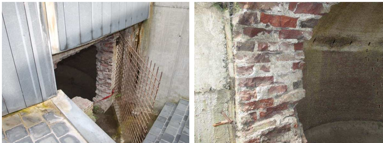
Figuur 34 – Huidige toegang tot de grootste ijskelder met zicht op de dikte van de wand
