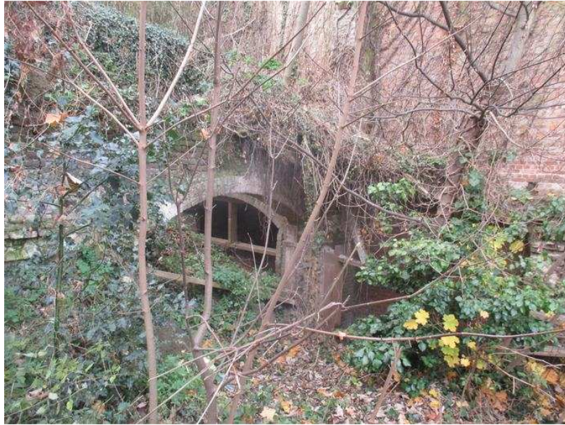
Figuur 22 – Overzichtfoto met zicht op de gordelboog in de gang tussen travee 1 en 2 (zicht vanop passerelle)
