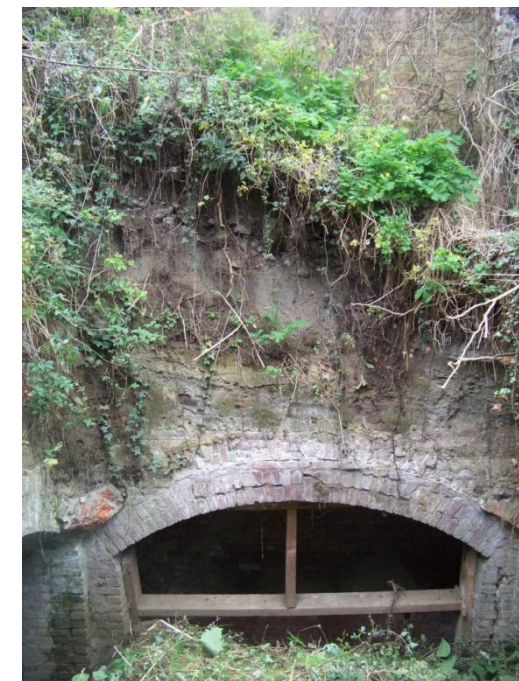
Zicht op de scheidingsboog van de keldervertrekken die haaks op de lengte-as van de tunnel geplaatst zijn, alleen de eerste meter van de kelder is overgebleven, de kelder werd afgebroken bij de bouw van de stookinstallatie. De scheidingsgevel die boven het gebladerte uitsteekt, sluit de kelder af.
