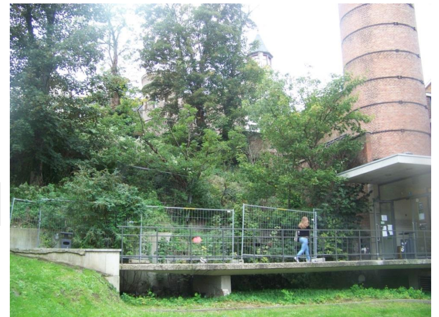
Zicht op de ingestorte gewelven van de keldervertrekken en "verborgen" tunnelingang
