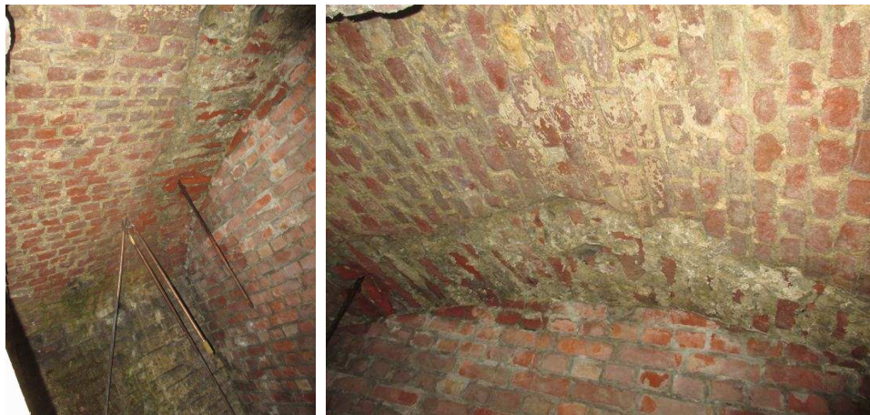
Figuur 13 - Tongewelf boven noordelijke kelder 1 (onderzijde)
