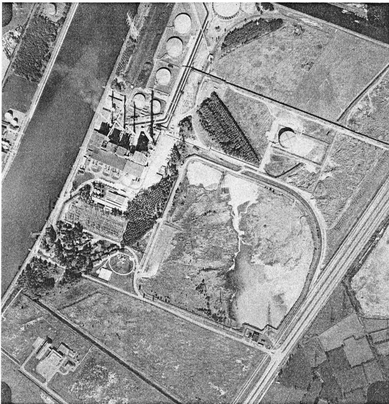
Foto 1 - Luchtfoto van de EBES centrale van Rodenhuijze (Aero-Survey, Sint-Niklaas) (1979)
