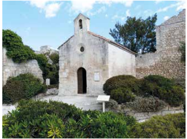
2 Chapel of Sainte Blaise, Les Baux de Provence.
