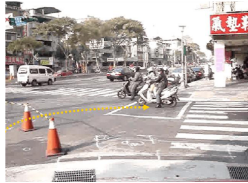
圖 11 承德橋北向承德-通河路口，右轉車輛與通河街路口停等待轉區相衝突(左上方綠色框處)；最外側機慢車道右轉轉彎半徑同樣不足易肇事撞致承德橋邊欄杆(左下方綠色框處)。資料來源：本研究繪製。
