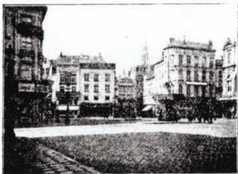
DE VERBREDEDE MEIRBRUG IN HAAR EERSTE STADIUM.
