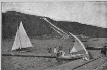
De Hengsteysee stroomafwaarts van Hohensyburg. Op het achterplan het «Rheinisch-Westfälische Elektrizitätswerk». Op den top van den berg, het pompstation dat 's nachts water van den vijver opvoert om, over dag, bij middel van turbines, aansluitende elektrischen stroom te verwekken. De waterleidingen zijn duidelijk te onderscheiden.
