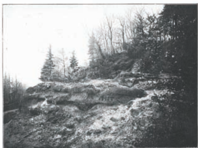
Un talus couvert de végétation variée avec allègement d'un banc gréseux.
