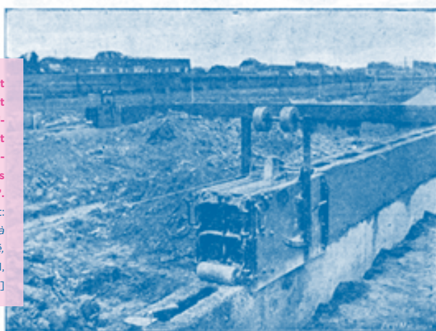
Fig. 6. — Chantier d'expériences de nouveaux matériaux et procédés de construction à Anderlecht. — Murs construits à l'aide du système « C. D. L. » — Le cliché représente la position du moule pour la construction de la deuxième assise. Le système « C. D. L. » consiste à ériger les murs en béton, directement à l'aide d'un appareil mobile, destiné à cet effet, et qui supprime l'emploi du coffrage.
