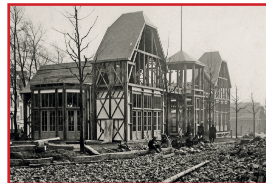
Zoals vele andere paviljoenen op de tentoonstelling werd ook dat van Vooruit opgebouwd met behulp van een techniek waarbij een houten of stalen geraamte bekleed werd met pleister. (Stad Gent, De Zwarte Doos, Stadsarchief)
