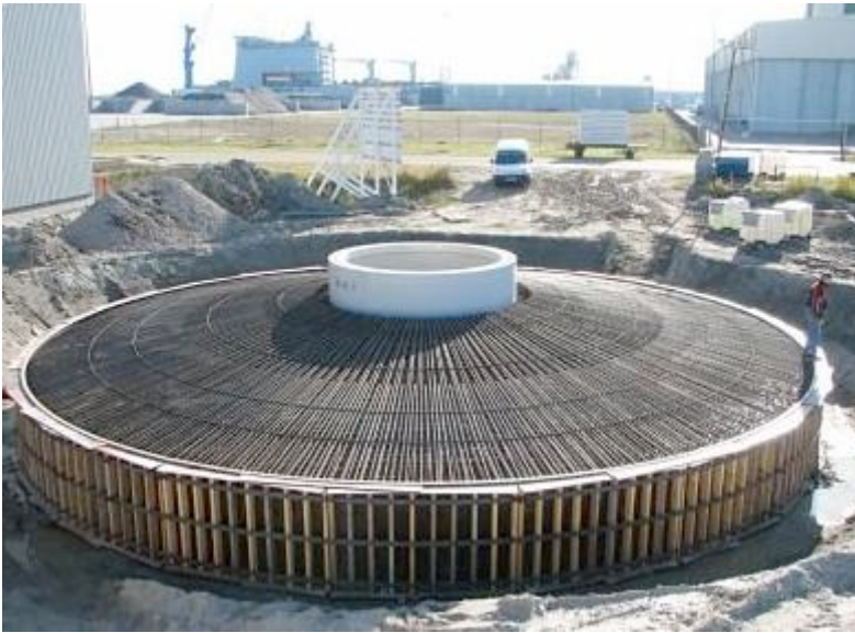
Figuur 5: fundering van een windturbine (foto: betoncentrale Eemsmond)
