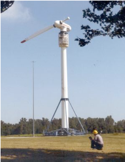
Figuur 1: Amerikaans prototype van een eenbladige turbine (1979)
