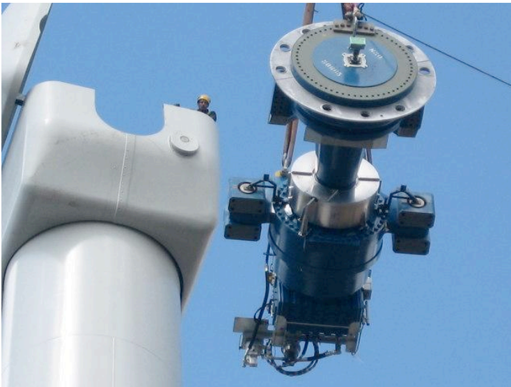
Figuur 6: ingenieurs hijsen het geheel van overbrenging en remschijf naar boven (Foto: Paul Anderson)
